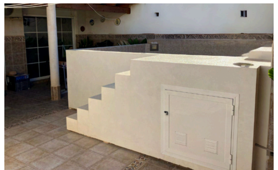
Escalera + Cuarto Técnico
